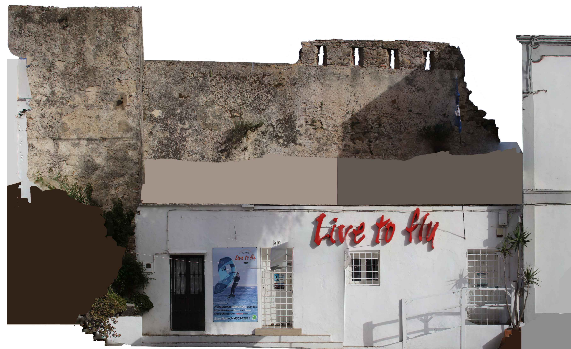
TORRE 2, al norte de la Puerta de Jerez
